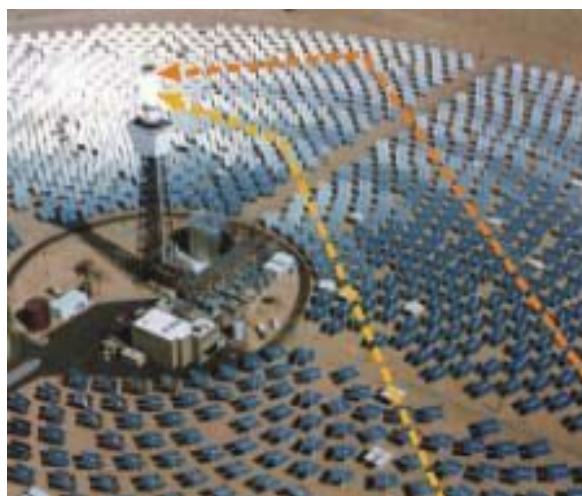
Solarna elektrana sa rotirajućim ogledalima
