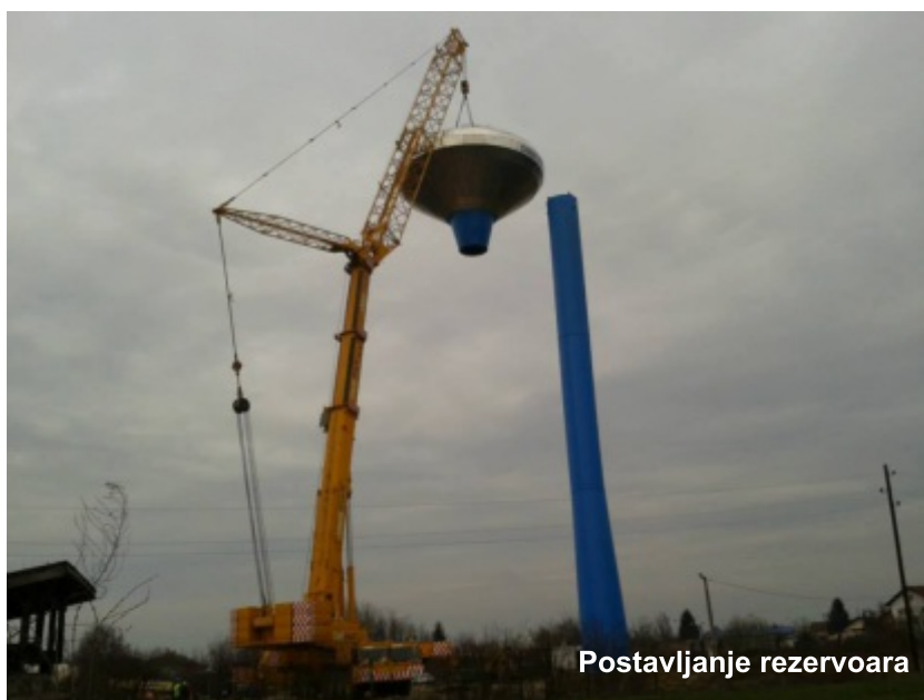
Rezervoar u izgradnji
